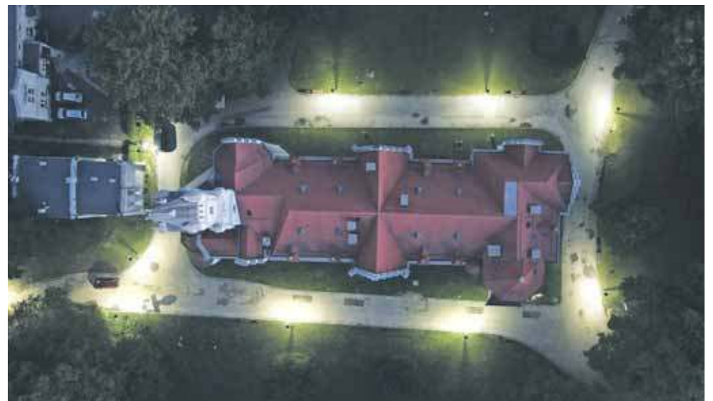
W 2018 r. dzięki Budżetowi Obywatelskiemu Powiatu Tarnogórskiego mieszkańcy Nakła Śląskiego, można powiedzieć, że odzyskali pałacowy park, który po zmroku tonął w ciemnościach. Budowa nowego oświetlenia poprawiła bezpieczeństwo i umożliwiła korzystanie z parku także późnym wieczorem
