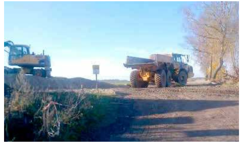
Już budują drogę dojazdową do fermy
