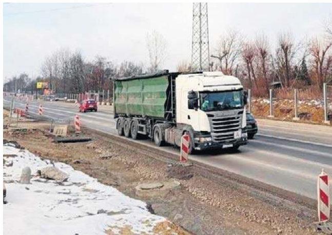
Oddanie do użytku nowego odcinka drogi planowane jest we wrześniu, a finał prac – na drugą połowę 2026 r.
