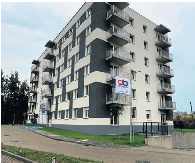
Nowe bloki Osiedlu Naftowa w Sosnowcu. Podobne mają się pojawić przy ul. Norwida w dzielnicy Środula
