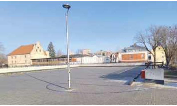
Górny poziom parkingu zyskał nową nawierzchnię
