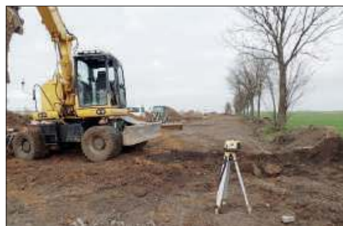
Przebudowa drogi powiatowej w Kornicach
