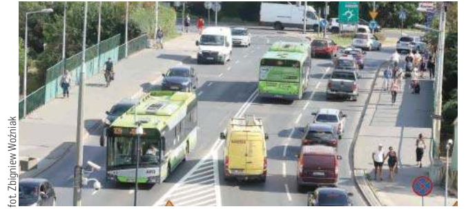
Wiadukt przy rondzie Bema czeka remont
