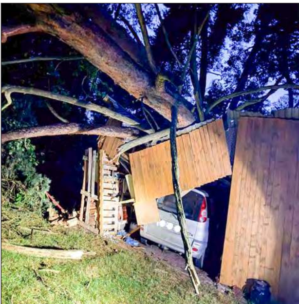
W Woli Łaskarskiej drzewo runęło na garaż, niszcząc budynek i znajdujący się w nim samochód
