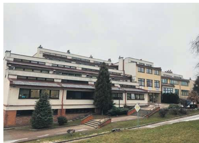
Wykonawca ma zacząć prace od demontażu starej instalacji
