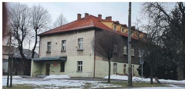
Szkole muzycznej z siedzibą przy Mickiewicza na razie niespieszno do przeprowadzki. Ma nowy dach
