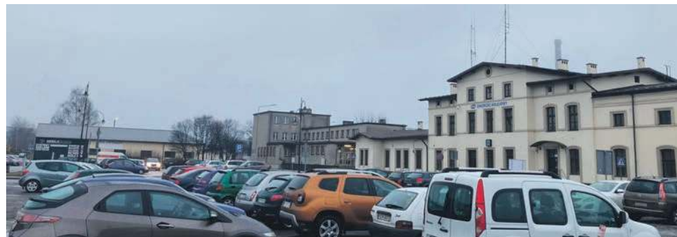
Nowy parking przy dworcu PKP w Trzebini ma być gotowy do końca roku
