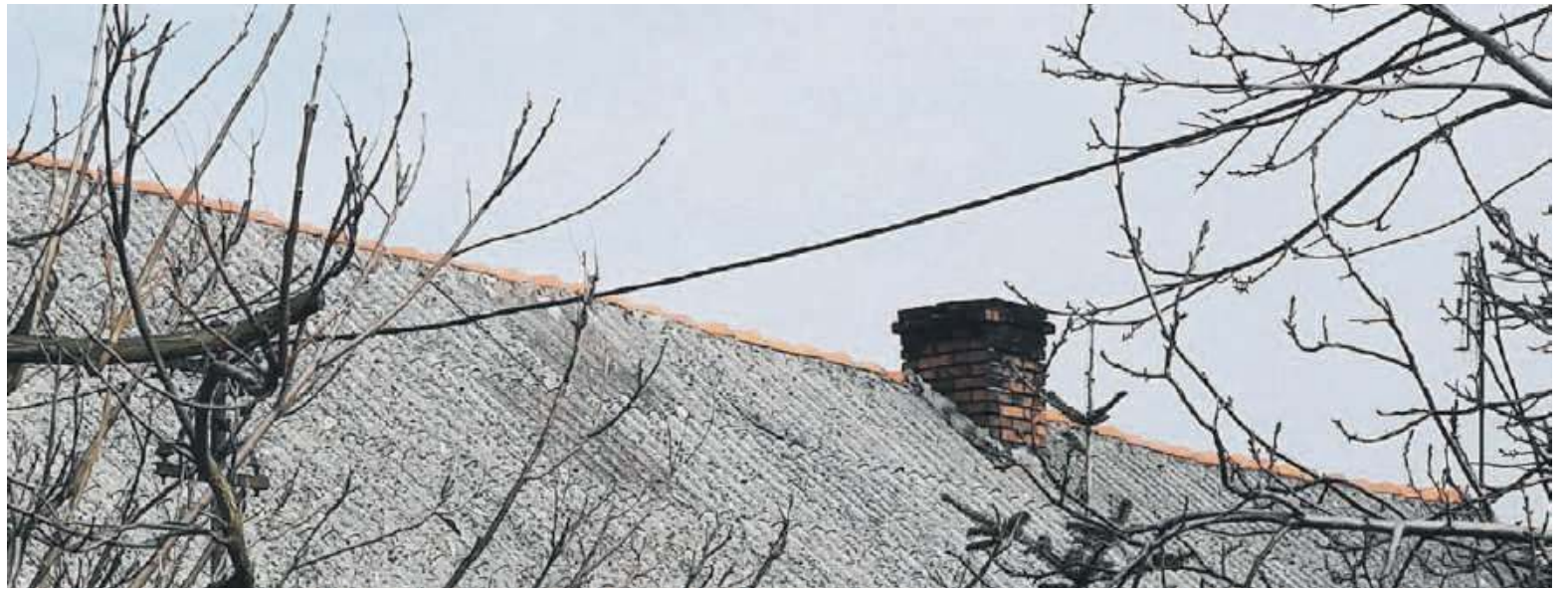
Dach kryty eternitem
