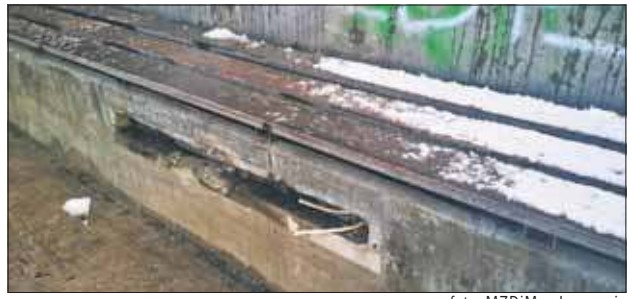
Wandale wyrwali 26 lamp
