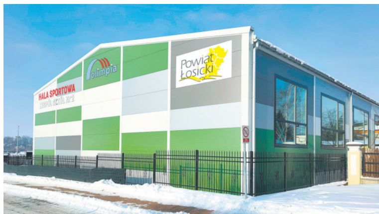
Hala ma dach dwuspadowy
