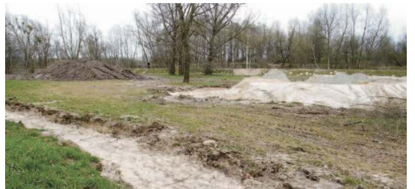
W parku zimnej wody powstaną tor rolkarski i pumtrack, stawy z wykorzystaniem naturalnej retencji wód oraz ciągi komunikacyjne. Zadanie pochłonie nieco ponad 7,7 mln zł
