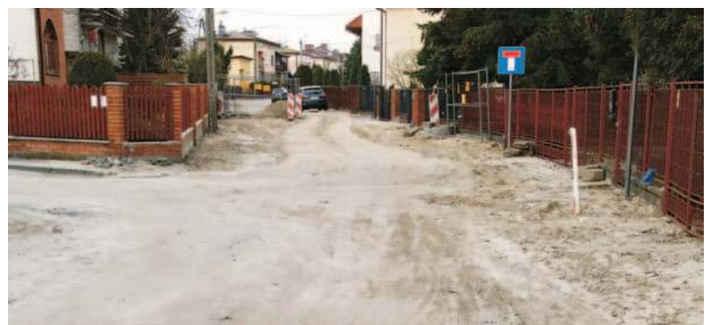
W ramach zadania przebudowy ulicy Krzywej, remontu doczeka się również ulica Wędkarska
