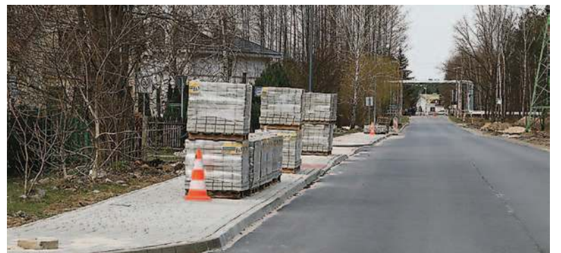
Również na wiosnę odświeżane jest osiedle Hutnik. Nowe chodniki powstają między innymi na ulicy Sosnowej
