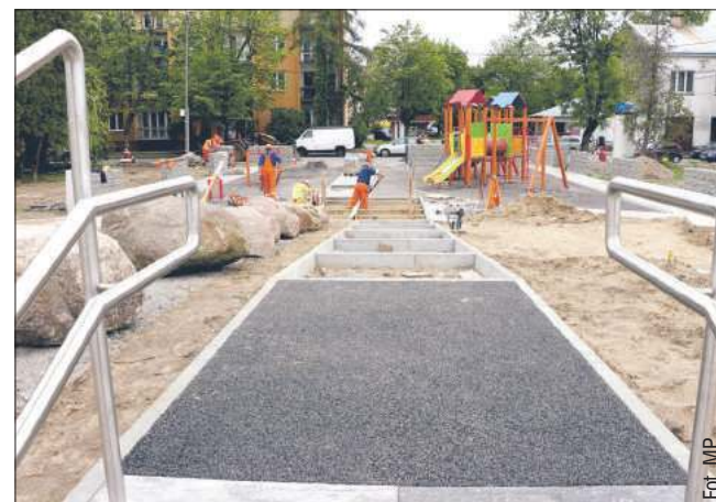
W parku montowane są już elementy małej architektury.
