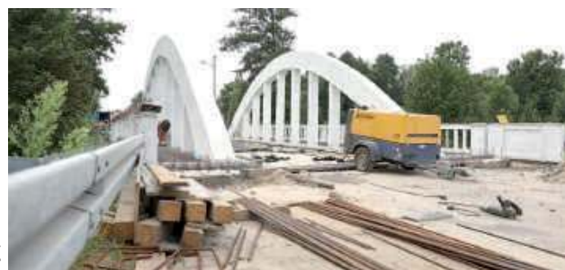
Remont obejmuje wymianę nawierzchni asfaltowej, odtworzenie stożków oraz wykonanie schodów skarpowych do obsługi technicznej
