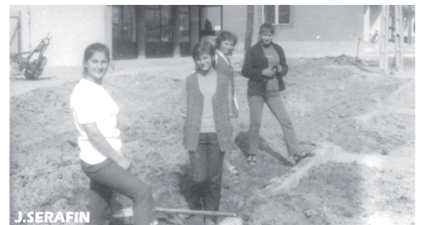
Dom obok 'Praktycznej Pani'. Dziewczeta przy budowie chodnika.
