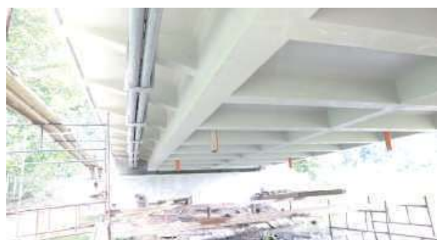
Od maja most jest zamknięty i przechodzi kompleksowy i gruntowny remont
