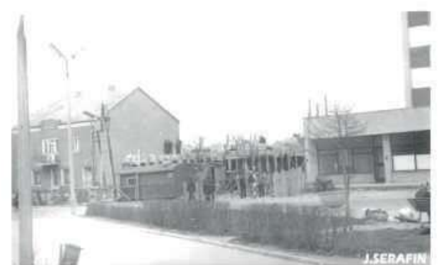
Budowa budynku 'Praktyczna Pani'.
