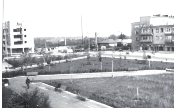
Budowa bloku mieszkalnego gdzie obecnie jest poczta i fundamenty pod późniejszy blok z 'Eldorem'.
