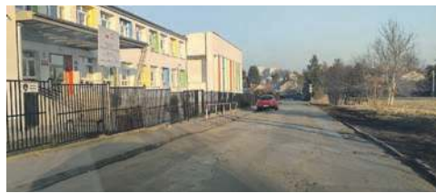
Przy wyremontowanej Dworskiej w Kościelcu, naprzeciwko SP 6, powstanie parking
