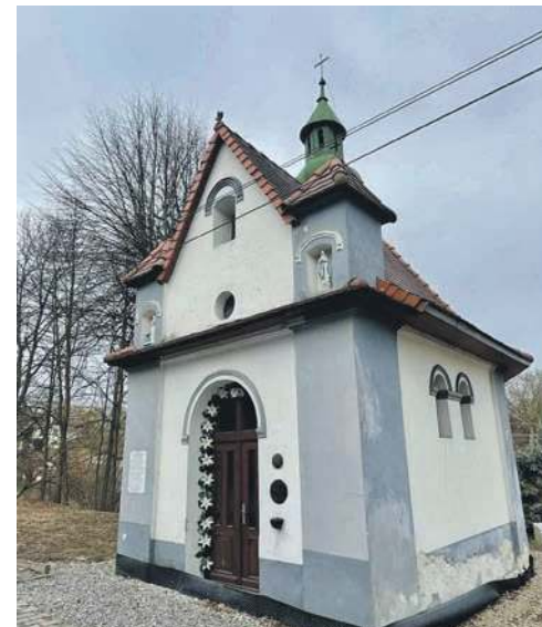
Zostanie odnowiona kaplica przy ul. Głowackiego w Grojcu
