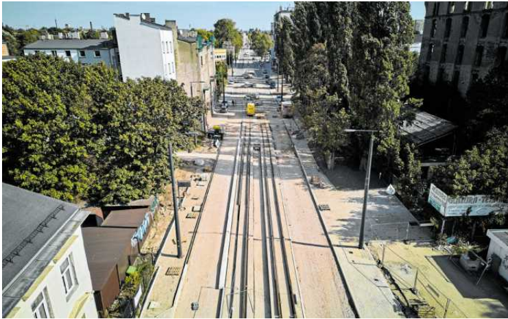
• Srzyżowanie ulic Przybyszewskiego i Kilińskiego, przebudowa torowiska tramwajowego FOT. TOMASZ STAŃCZAK / AGENCJA WYBORCZA.PL
