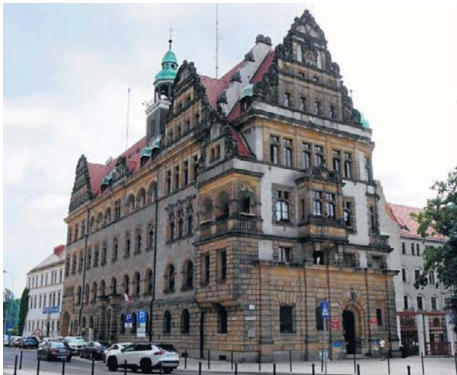
Budynek powstał w latach 1902-1905
