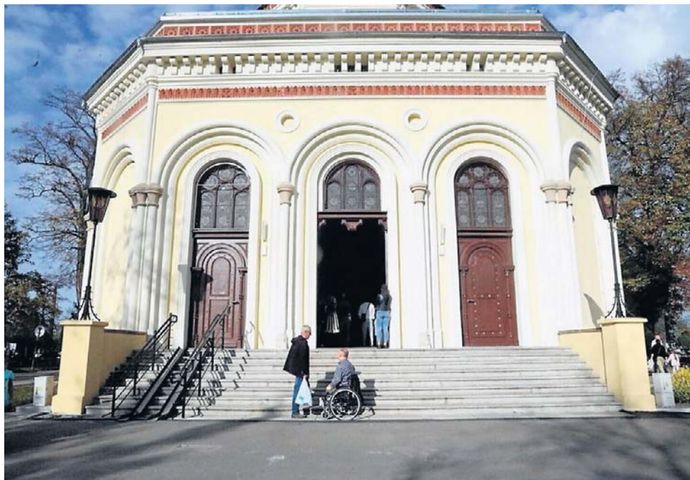
Zbyt stromy podjazd na schodach do kaplicy cmentarnej - nie do samodzielnego użytku
