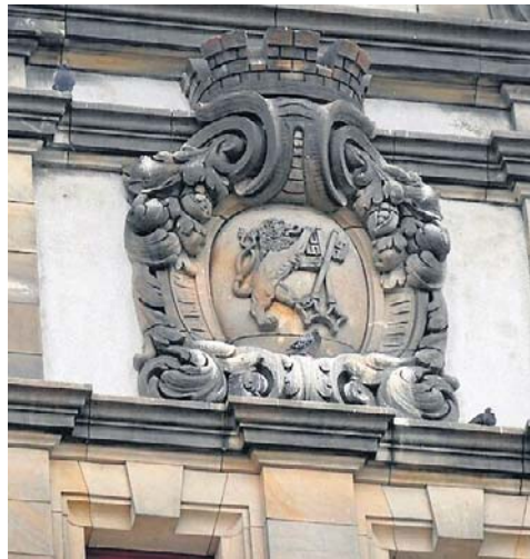
Fasada od strony placu Słowiańskiego, ul. Św. Piotra i ul. Witelona
