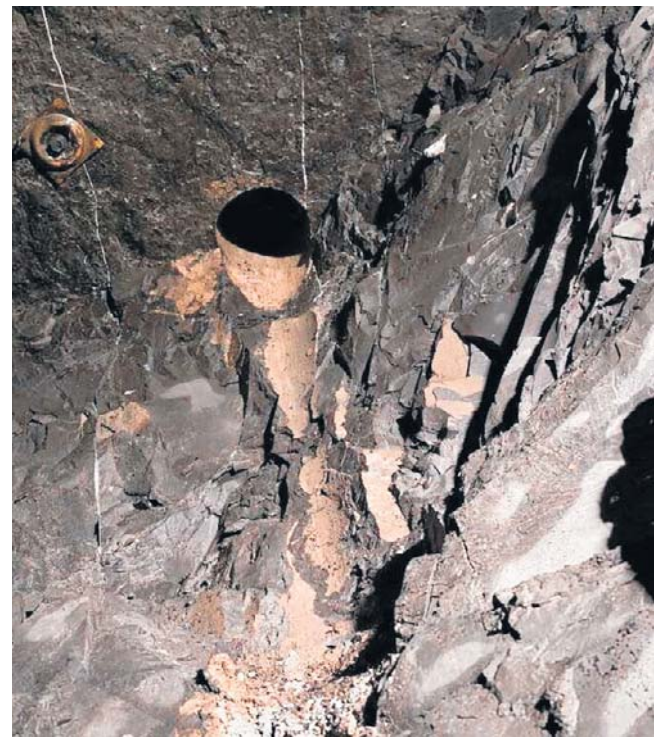
Wyrobisko wykonane przez górników przecięło historyczny odwiert, który zachował się w dobrym stanie
