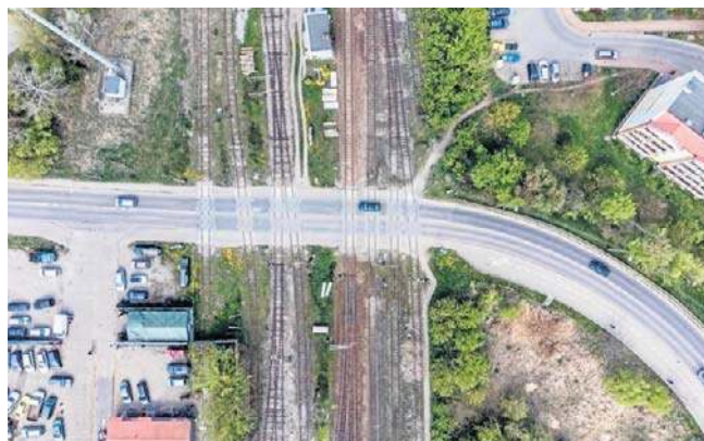
W ramach inwestycji m.in. na ulicy Popiełuszki w Białymstoku powstanie bezkolizyjna przeprawa nad torami
