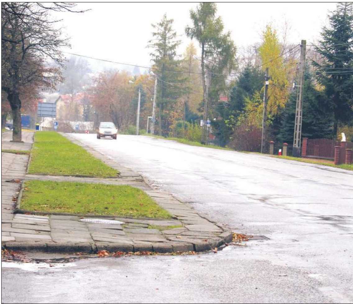
Ulica Legionów doczeka się przebudowy. Roboty pochłoną cztery miliony złotych.
