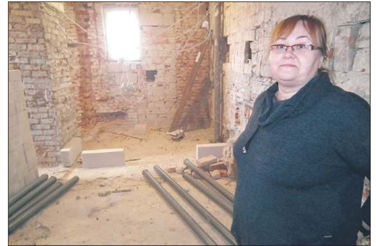
Marta Skórska pokazuje łazienki, w których właśnie trwa remont.
