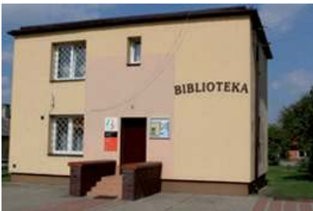
Obecny budynek będzie rozbudowany, a jego powierzchnia wyniesie 700 metrów kwadratowych (fot.wojcieszkow.naszabiblioteka.com/galeria)
