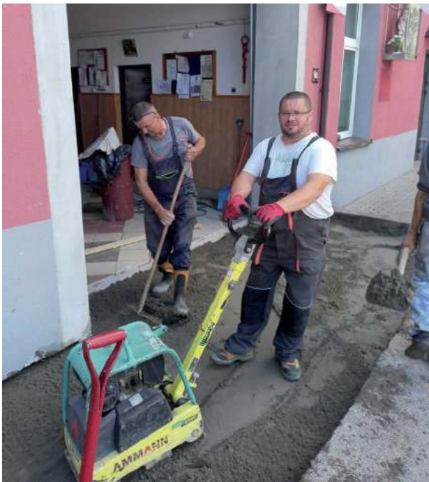
W prace zaangażowali się nie tylko strażacy, ale i pozostali mieszkańcy Serokomla. Wspólnymi siłami ułożyli chodnik z kostki przed remizą (fot. OSP KSRR Serokomla)
