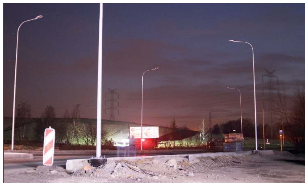
Obecnie większa część remontowanego odcinka jest spowita ciemnością
