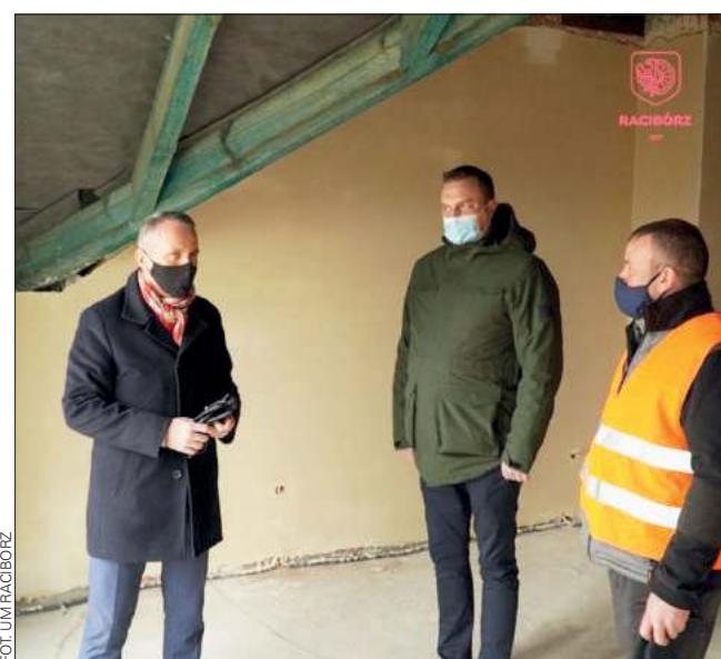
Drugi budynek osiedla na Łąkowej jest w stanie surowym zamkniętym. – Trwa etap robót wykończeniowych, elewacyjnych, związanych z tynkowaniem ścian i wylewkami wewnątrz budynku – informuje Bartłomiej Głowacki z firmy Borbud, która buduje blok. Na zdjęciu pierwszy z prawej, obok niego stoją prezydent Raciborza Dariusz Polowy i prezes TBS Leszek Wenda
