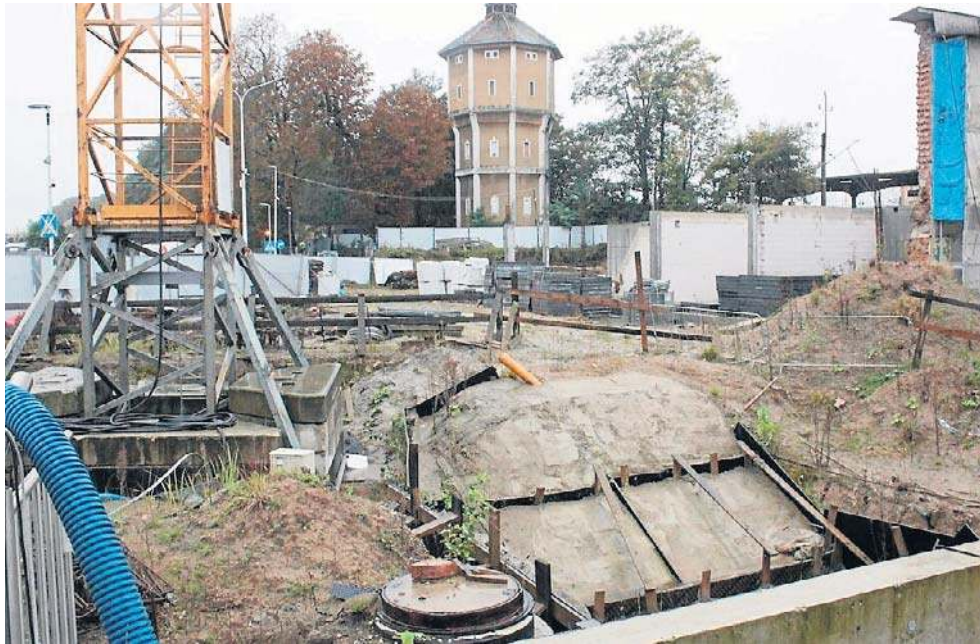
Na początku 2024 roku ustały prace przy budowie koszalińskiego dworca kolejowego
