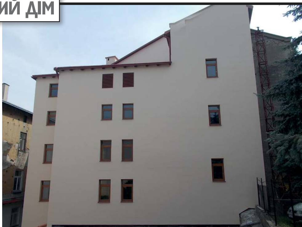
▲ Західна частина Народного дому після ремонту
