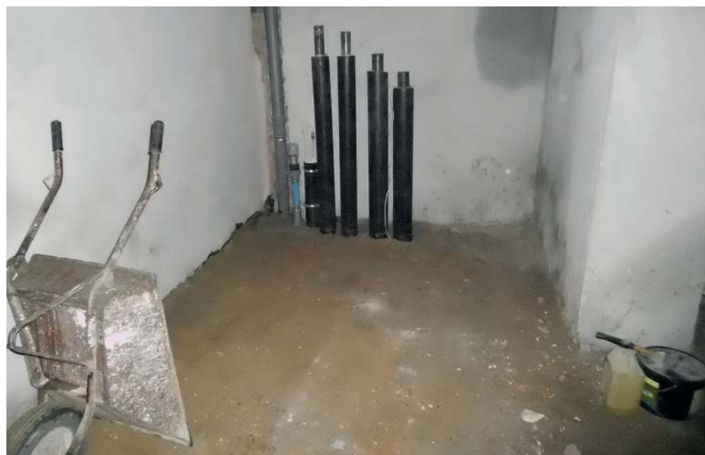
▲ Місце перед побудовою і облаштуванням котельні
