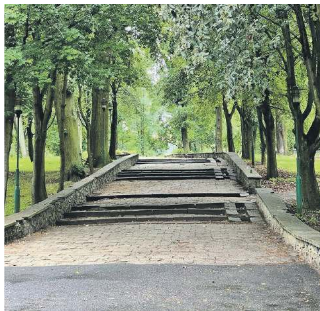
O dziwo, gmina tak okroiła kosztorys, że z przetargu wyleciał nawet remont schodów wejściowych
