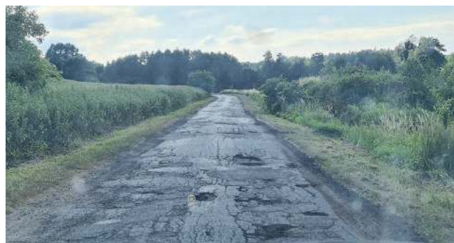
Odcinek drogi powiatowej Rzepotowice - Kowale
