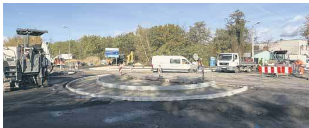
Budowa ronda na DK 79 w Jaworznie
