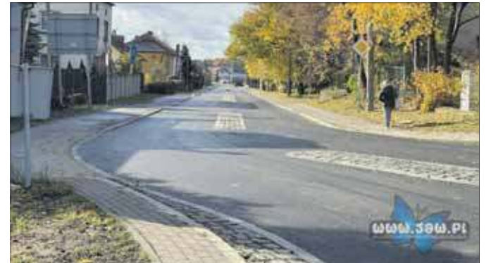
Ulica Jaworzniacka po remoncie. Droga została otwarta
