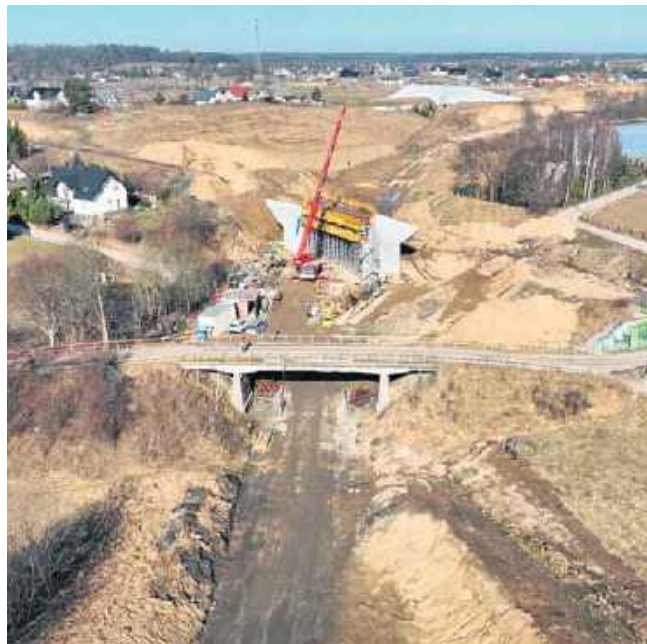
Linia 201 przechodzi intensywną przebudowę
