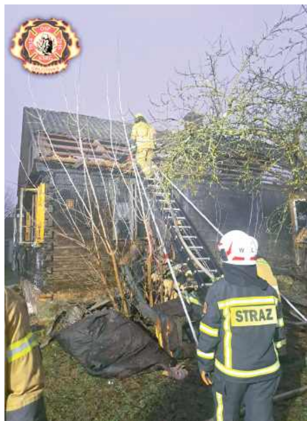
27 grudnia. Pożar budynku mieszkalnego
