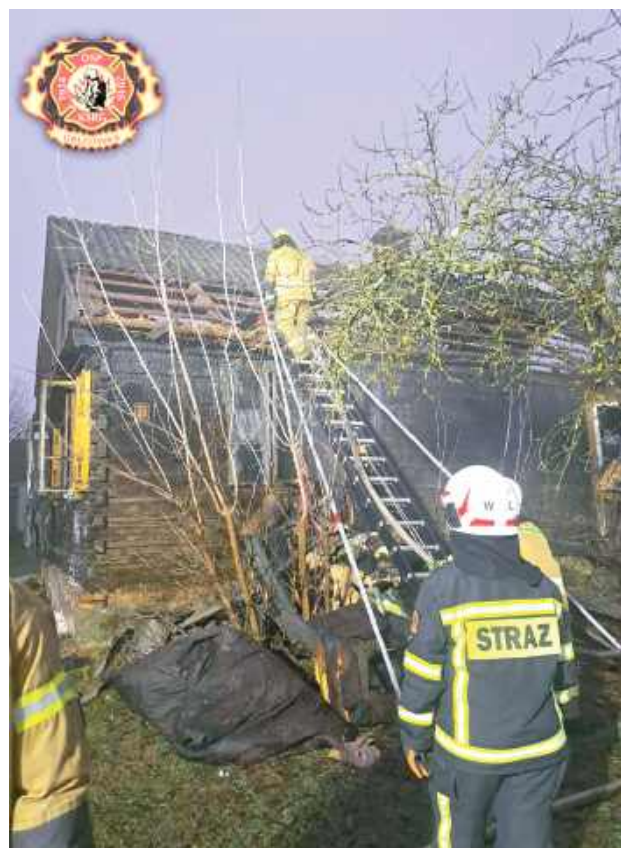
27 grudnia. Pożar budynku mieszkalnego
