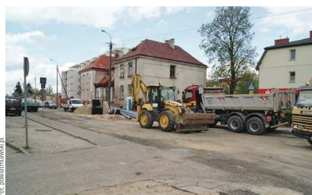
Prace przy budowie ronda idą pełną parą
