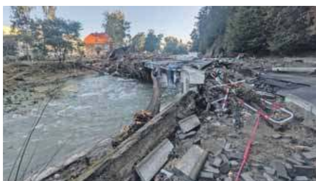
– Zdjęcia nie pokazują tego, co zastaliśmy na miejscu – komentował Joachim Soll
