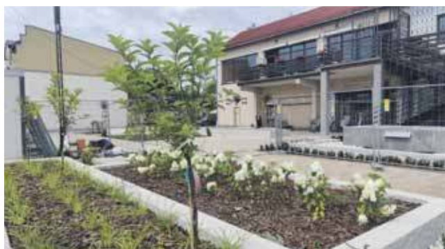
Roboty dobiegają końca, w zasadzie do wykonania został basen – akcent wodny o powierzchni ponad 8 metrów kwadratowych. Ma być ozdobą przebudowanego centrum FOT. UM KALETY
