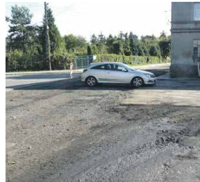
Remontowany jest fragment ul. Górniczej w Tarnowskich Górach od skrzyżowania z ul. Ogrodową do skrzyżowania z obwodnicą FOT. AGNIESZKA RECZKIN
