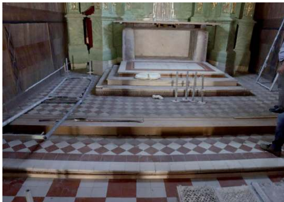
Zerwana posadzka, usunięty drewniany podest przy prezbiterium i porozkładane dookoła płytki. To już historia, bo remont w kościele w Górecku Kościelnym właśnie się zakończył
