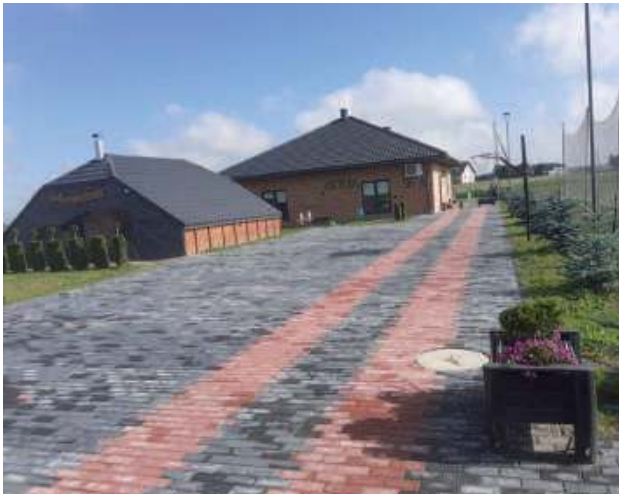
Świetlica „Ostoja” w Olszance zaczyna już przypominać prawdziwy kompleks
