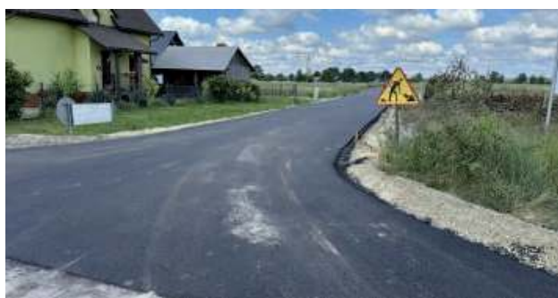
Droga asfaltowa w Aleksandrowie przylega do ulicy Wesolej
