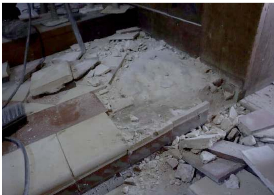
Posadzka kościoła w Górecku Kościelnym wykonana była z przedwojennych płytek podłogowych
