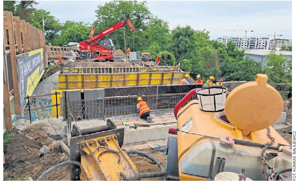
Pod konstrukcją przygotowują fundamenty, a wykonawca czeka na osiągnięcie przez beton odpowiedniej wytrzymałości.
