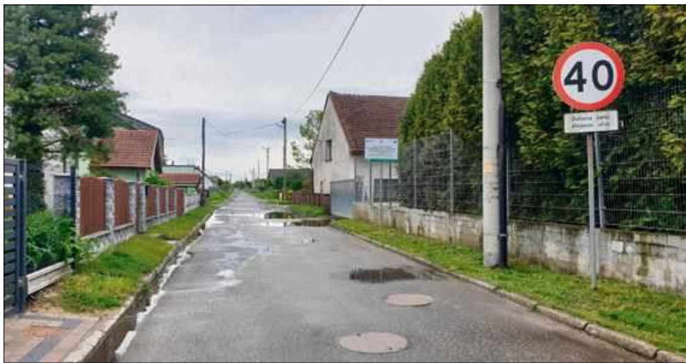
Remont ulicy Wschodniej w Zdzeszowicach został dofinansowany z rządowych pieniędzy.
