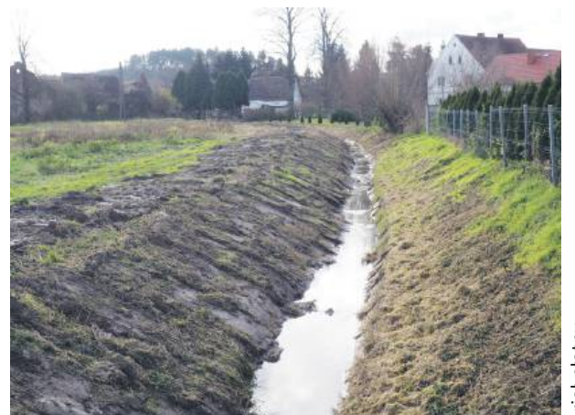
W Nieszkowicach widać już efekty prac.
