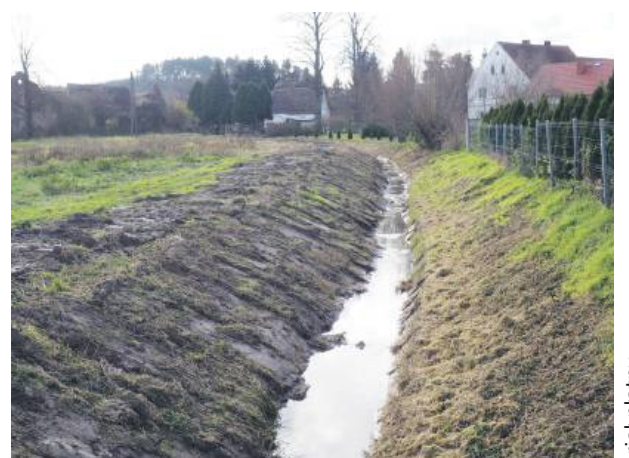
W Nieszkowicach widać już efekty prac.
