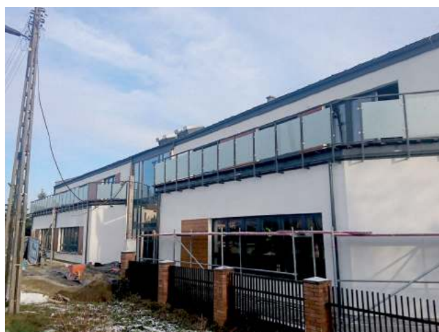
Obecnie na miejscu wykonawca dokonuje końcowych poprawek. W najbliższych dniach odbędzie się odbiór prac
