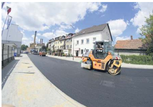
Jak informuje burmistrz Dorota Pawnuł, wykonawca przełożył części chodników, które zostały zakwestionowane przez inspektora nadzoru. Do czasu odbioru inwestycja pozostaje terenem budowy. Foto: UMig Strzelin
