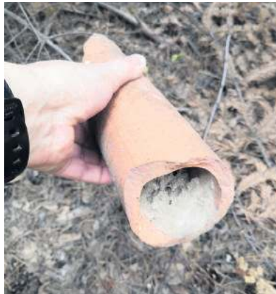
Takie niepozorne, ceglane rurki drenarskie odpowiadają za przepływ wód na polach
