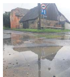
W niektórych miejscach woda stała jeszcze długo po deszczu
