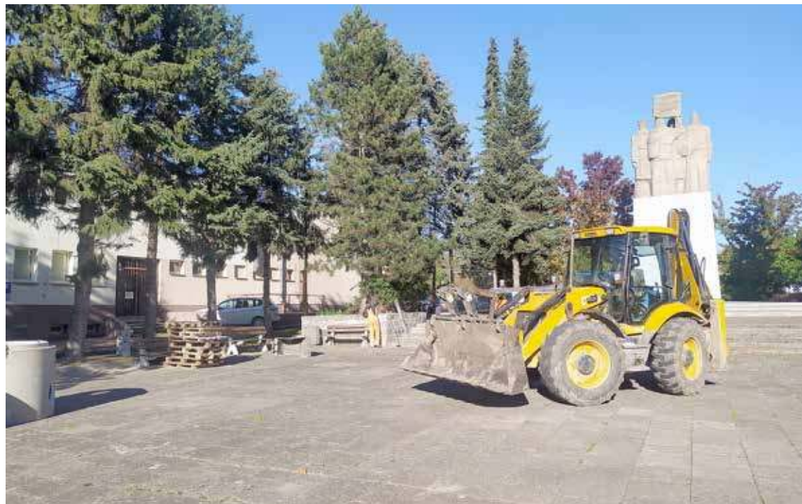
Prace przygotowawcze związane z przebudową kanalizacji za pomnikiem
