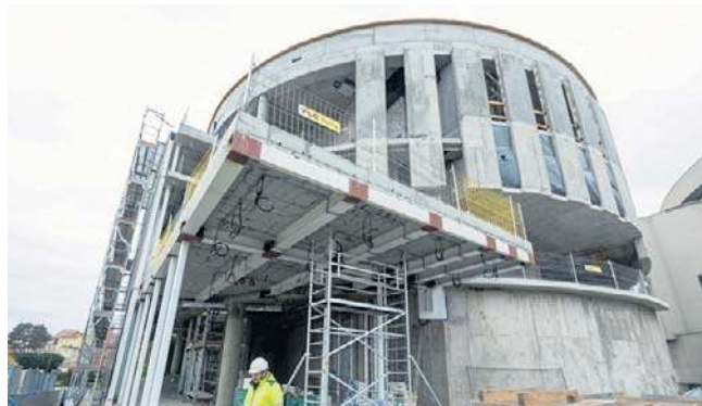
W ostatnich tygodniach w IV kręgu wykonywano szereg prac wykończeniowych oraz instalacyjnych
