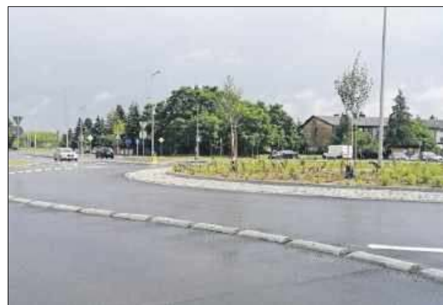
W ramach realizacji trzeciego odcinka ul. Armii Krajowej powstało rondo turbinowe na skrzyżowaniu z ul. Żeromskiego. Do takiego rozwiązania namówił władze miasta wykonawca
