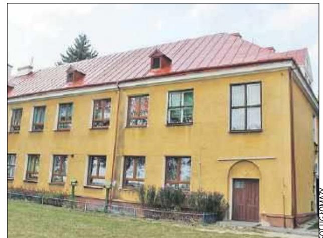
Umowa na remont pokrycia dachu Szkoły Podstawowej w Huszcz w gminie Łomazy podpisana
