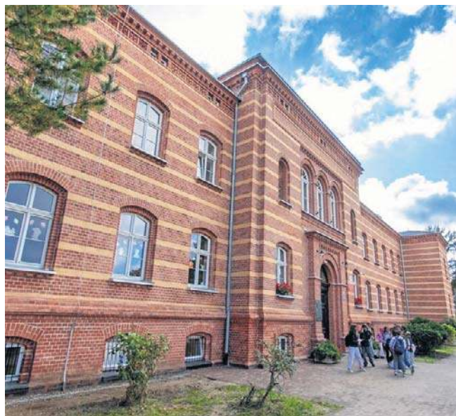
Budynek SP nr 1 w Słupsku pochodzi z XIX wieku, więc przy remoncie zadbano o jego zabytkowy charakter
