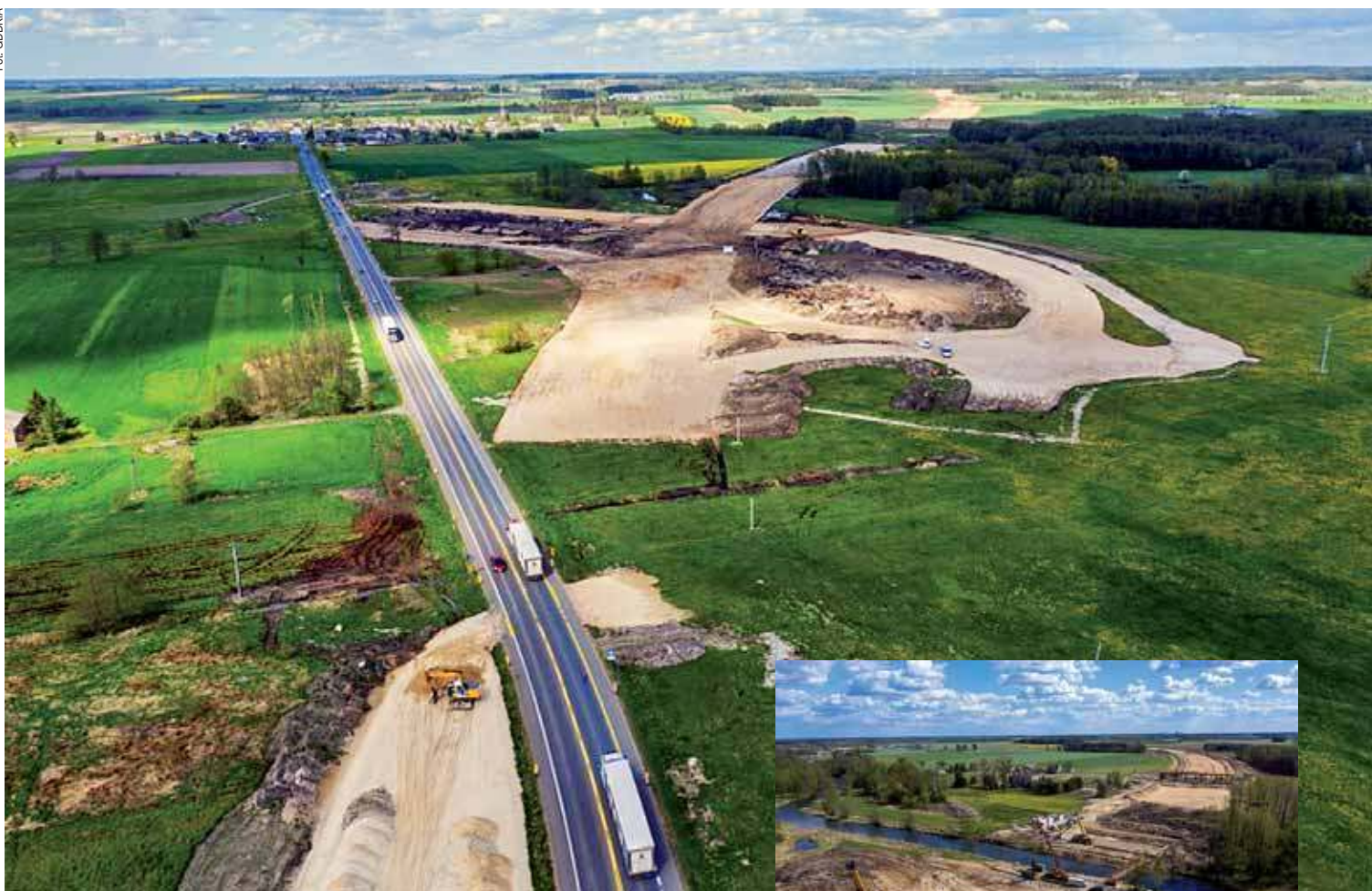
Inwestycja jest podzielona na cztery odcinki realizacyjne
