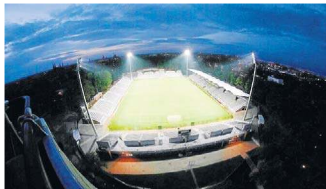
Dzięki modernizacji, powstało profesjonalne oświetlenie
