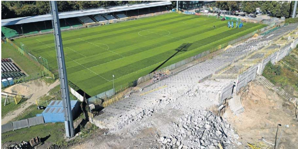
Na Oporowską wszedł już ciężki sprzęt. Zdemontowano krzeselka, teraz niszczone jest betonowa podstawa
