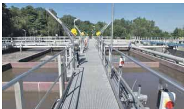
Po modernizacji wydajność oczyszczalni ma się zwiększyć
