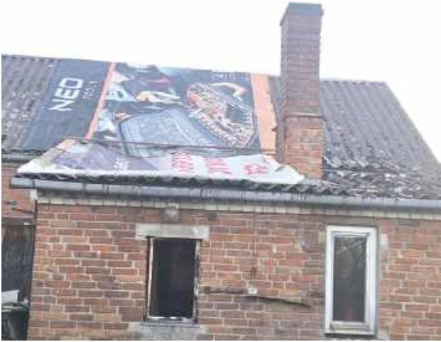
Po pożarze do wymiany jest cały dach z eternitu, który uszkodził się wraz z krokwiami. Ucierpiała też łazienka, korytarz i kotłownia.
