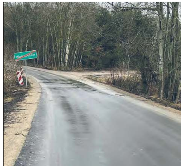
■ Już od miesiąca mieszkańcy gminy Ułęż i Jeziorzany mogą pokonywać odcinek łączący te miejscowości w pełnym komfortie (fot. Gmina Ułęż)
