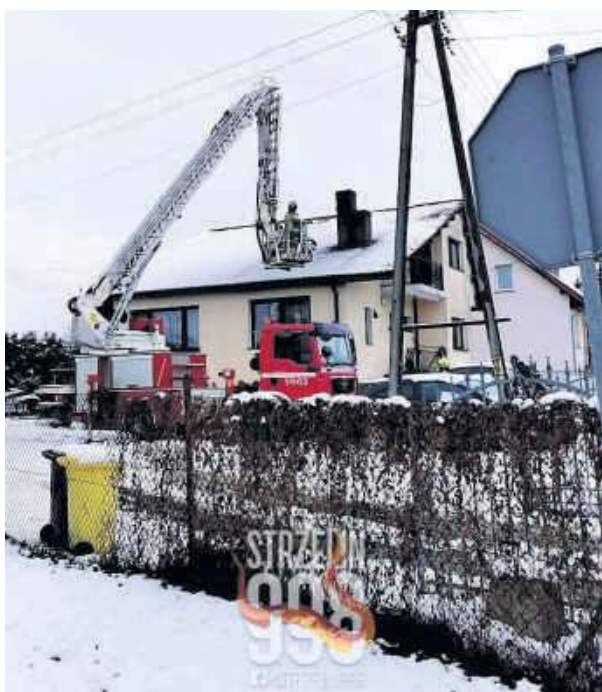
Po przybyciu na miejsce, strażacy wygasili piec centralnego ogrzewania. Foto: Strzelin998
