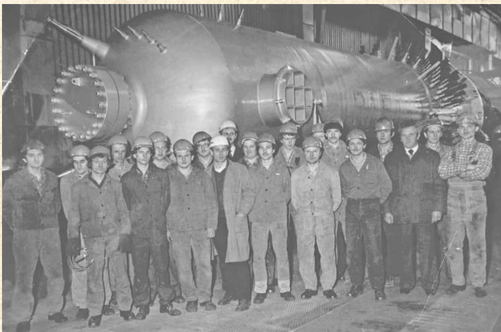
■ Przed stabilizatorem ciśnienia dla Elektrowni Jądrowej Nord w NRD stoją brygady wydziału energetyki jądrowej W4. Wśród pracowników Walenty Hiter, Roman Kieś, Hubert Kasza, Karol Klimanek i Krzysztof Matyszek.
