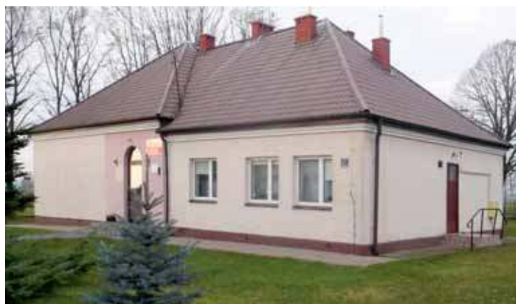
Obiekt szkoły w Grzebsku
