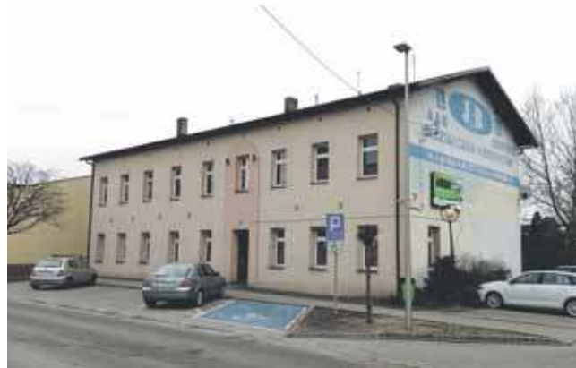
Kalety otrzymały 815 tys. zł dotacji na termomodernizację czterech budynków wielorodzinnych. Jednym z nich jest dom przy ul. 1 Maja
