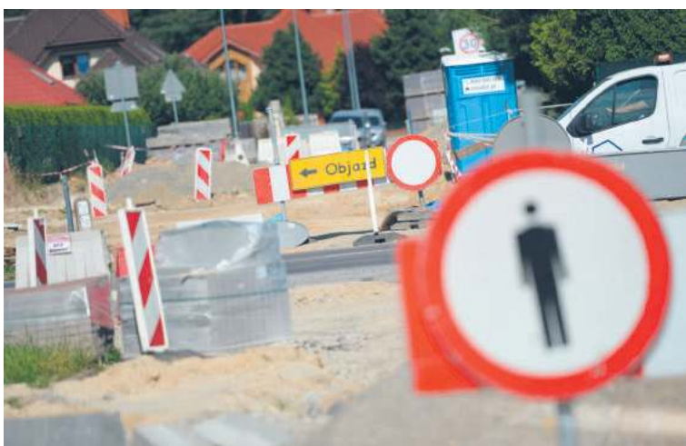
Poślizg na przebudowie ronda, bez względu na jego przyczynę, to zła wiadomość dla świdnickich kierowców
